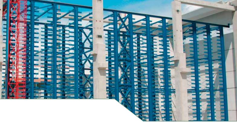
I magazzini Matter sono realizzabili in dimensioni diverse in funzione delle necessità del cliente e degli ambienti
